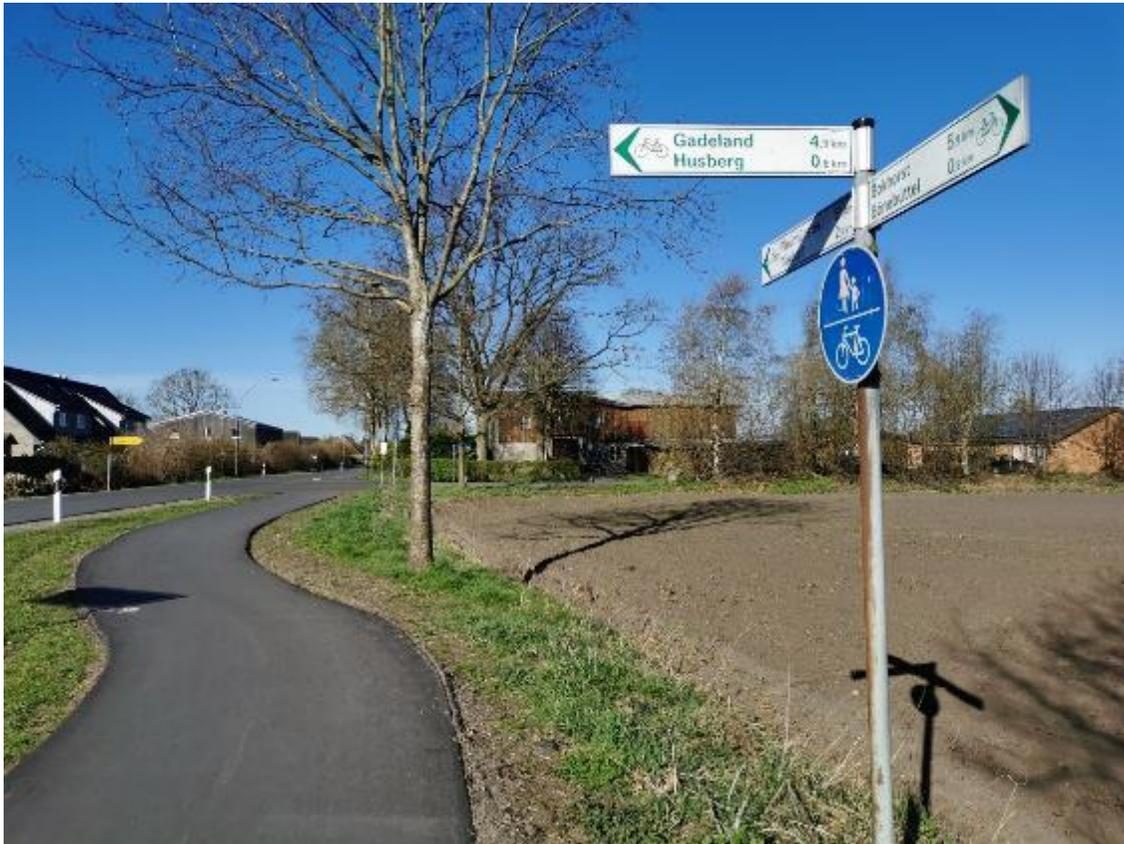
Beispielbild eines intakten Armwegweisers mit den Maßen 150 x 700 m (eigene Aufnahme)
